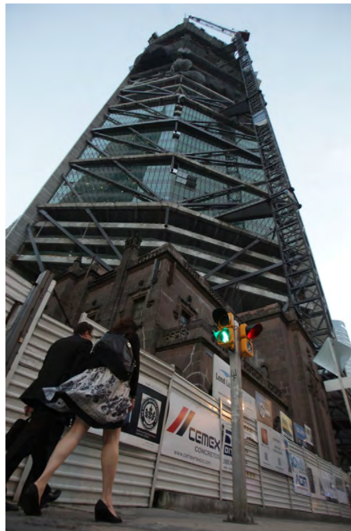
Figura 8. Conservación de la vieja casona porfiriana por la recién inaugurada Torre Reforma, en donde se movió y descontextualizó el edificio, pero se conservó. Fuente: archivo Juan Boites, El Universal ( http://www.eluniversaldf.mx/miguelhidalgo/torre-reforma-el-rascacielos-mas-alto-y-sustentable-del-df.html ).
