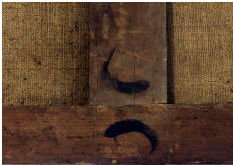
Figura 8. Marcas de armado, La Visitación , Alatorre-Borrero-Limón 2016.
