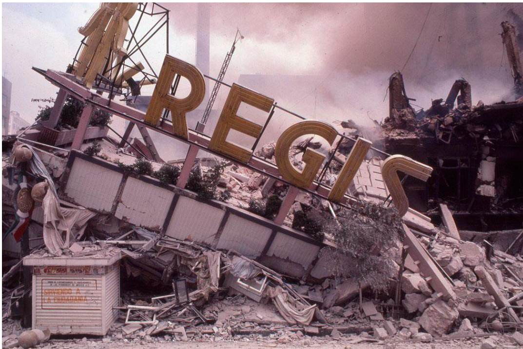
Fotografía 3. Hotel Regis colapsado
