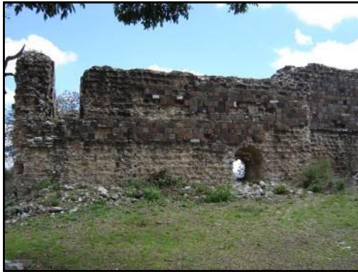
Figura 13. Vista general del muro sureste.
