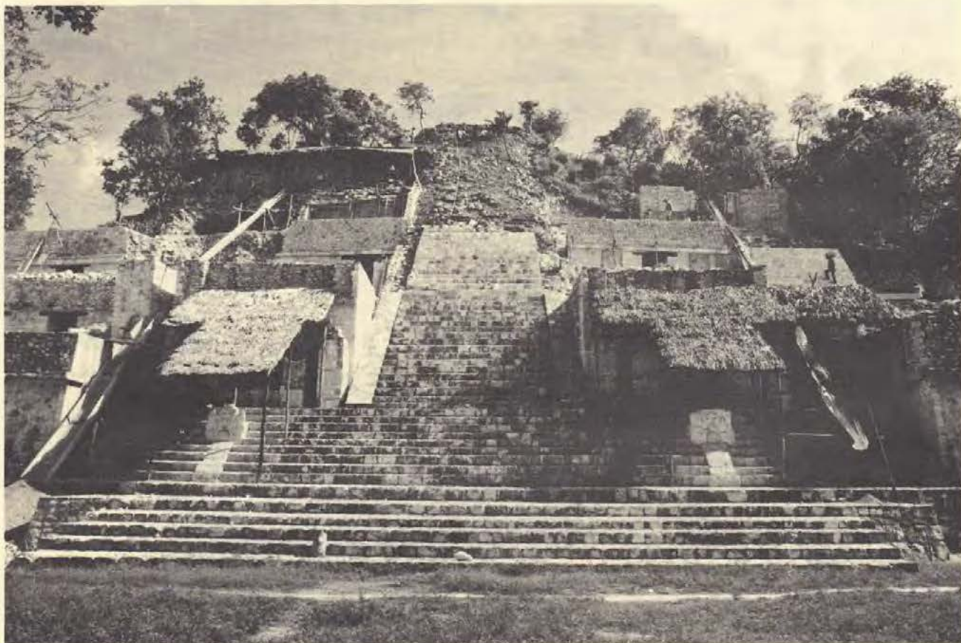
Foto 7- Vista parcial de la Estructura 1 ó La Acrópolis. En ella se trabaja actualmente, por lo que se aprecian las áreas parcialmente intervenidas, en la parte superior.
